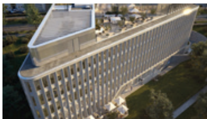
Vue du bâtiment Prism à la Cloche d'Or.
