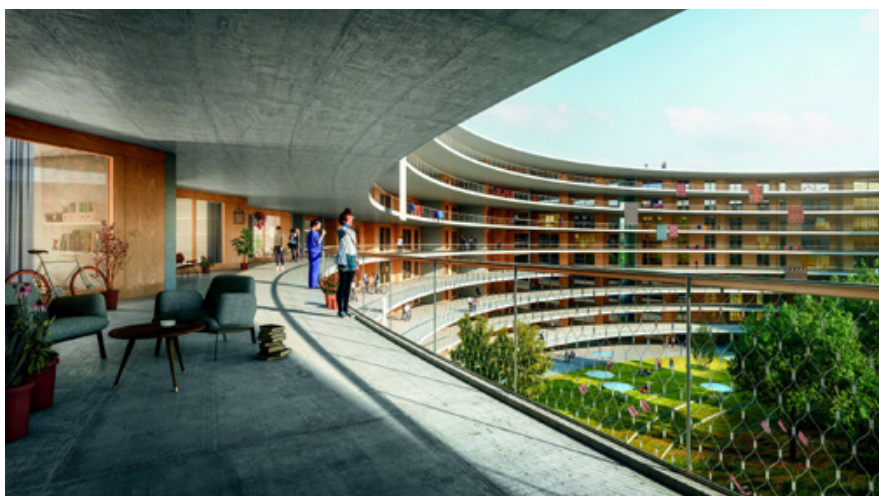
Le Vortex à Lausanne. Dessiné par Jean-Pierre Dürig en 2015 à l'issue d'un concours d'architecture et d'ingénierie, il est habité par des étudiants depuis 2019. Image de synthèse-Jean-Pierre Dürig architecte.
