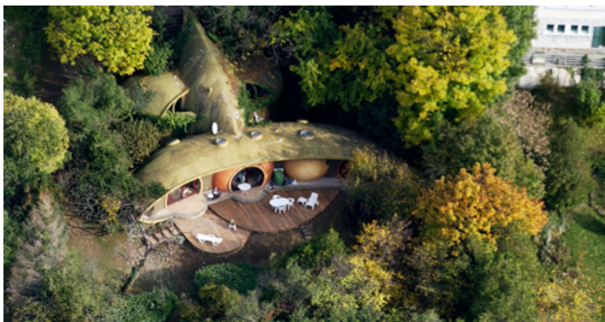
Maison familiale de l'architecte Jean-Louis Rey, dit Chanéac, conçue et réalisée entre 1974 et 1976, sur les hauteurs d'Aix-les-Bains. L'édifice est classé au titre des Monuments Historiques depuis 2017.
