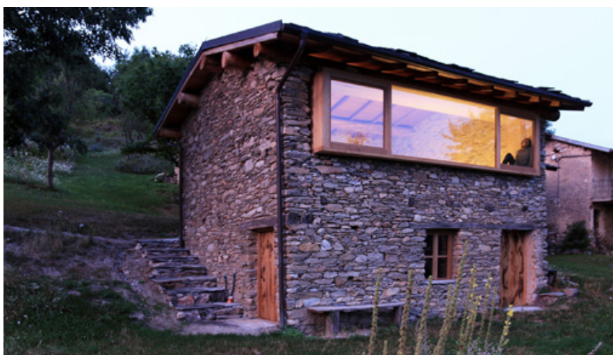
Rénovation d'un ancien bâtiment à Ormea en 2019, à la frontière entre Ligurie et Piémont, par le cabinet d'architecture Officina 82. Il servait autrefois d'écurie et de grenier.
