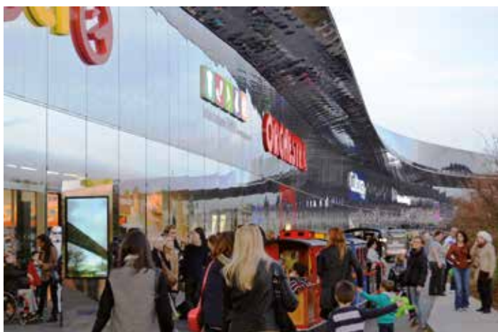
Le centre commercial Waves Actisud a été inauguré en grandes pompes en octobre dernier.
