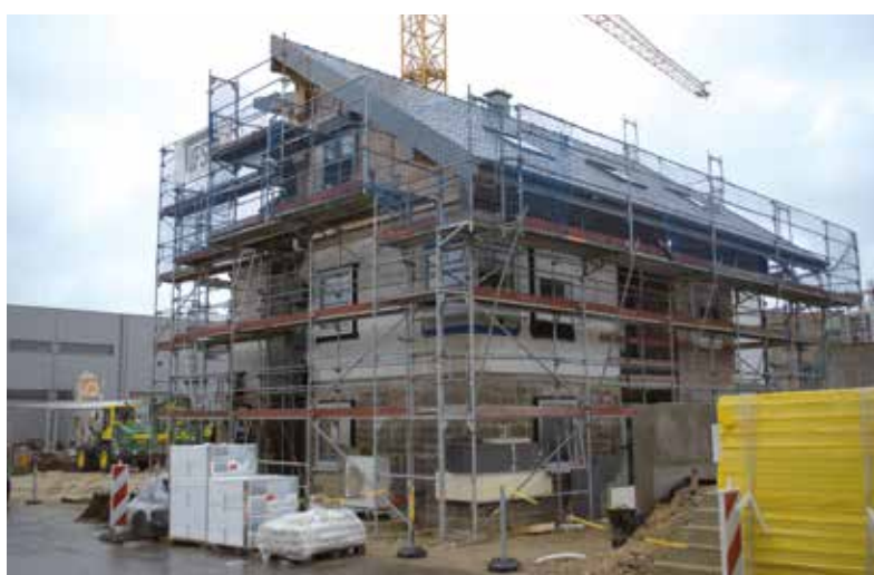
Vue du bâtiment didactique pour chantiers passifs.
