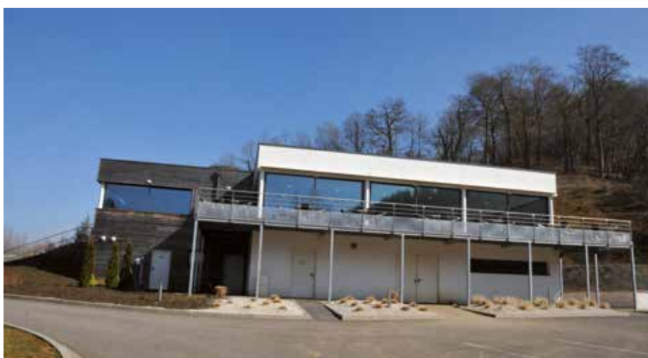
Le magnifique Club House surplombe toute la partie basse du parcours.
