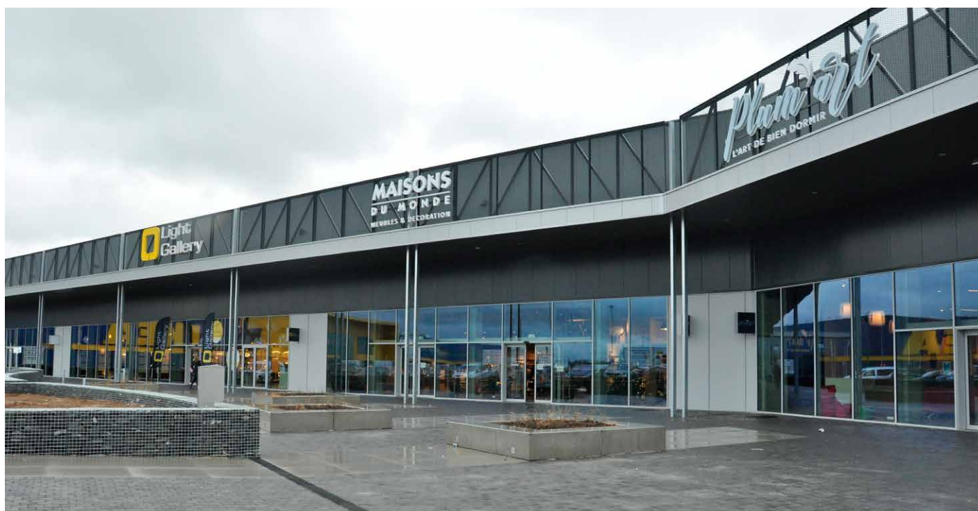
Vue du parc commercial de Sterpenich, dont l'extension vient de voir le jour.
